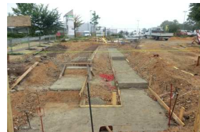
Vielzweckpodest im Bau Sep. 2012
