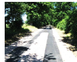
Spurbahnsanierung
