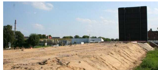
Auflast aus Sand am Nordufer
