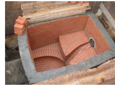
Bau Regenwasserkanal
