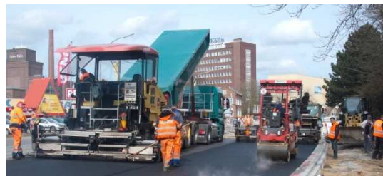
Asphaltierung am Südufer für die Kreuzung
