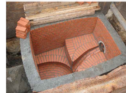
Bau Regenwasserkanal
