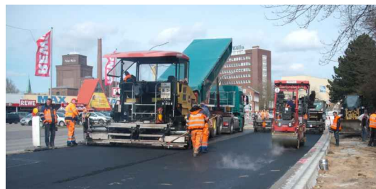
Asphaltierung am Südufer für die Kreuzung
