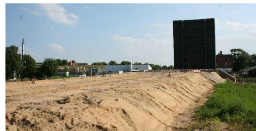
Auflast aus Sand am Nordufer
