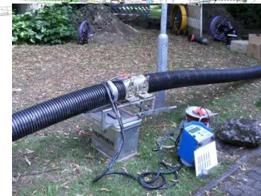
Einbau Flexoren-Rohr
