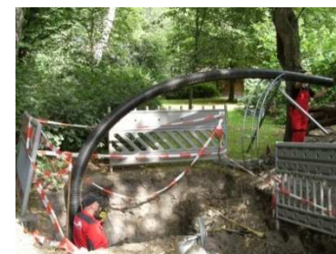
Einbau Flexoren-Rohr
