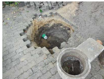
Schlauchliner Anschlussleitung
